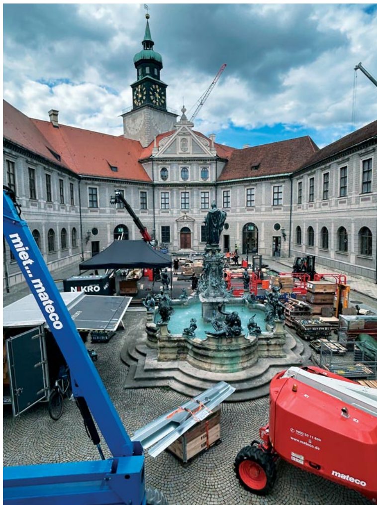
IAA Open Space in Münchens Innenstadt: logistische Arbeiten unter extrem beengten Platzverhältnissen.
